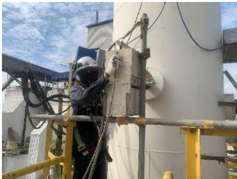
รูปที่ 2-28 การตรวจสอบเครื่องมือตรวจวัดคุณภาพอากาศจากปล่องอย่างต่อเนื่อง
