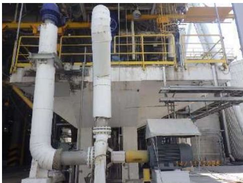
รูปที่ 2-21 การติดตั้งฉนวนกันความร้อนที่เครื่องจักร
