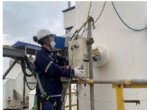
รูปที่ 2-28 การตรวจสอบเครื่องมือตรวจวัดคุณภาพอากาศจากปล่องอย่างต่อเนื่อง
